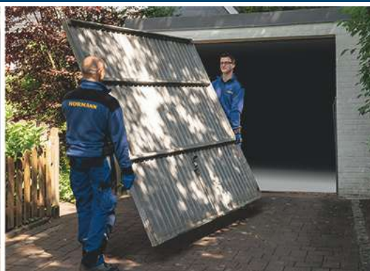
Ausbau und umweltgerechte Entsorgung
